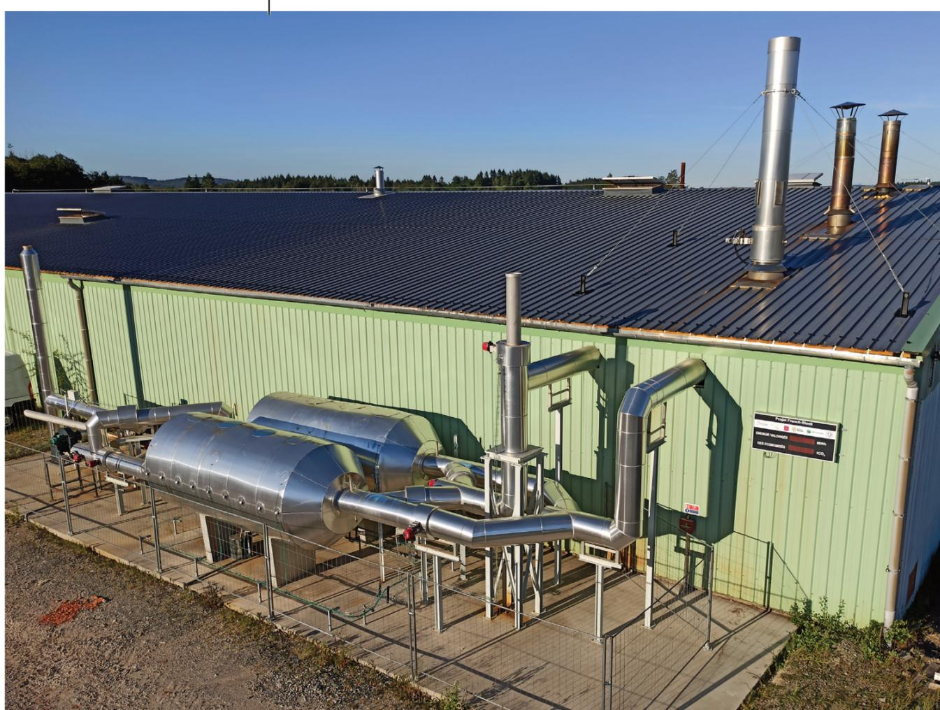
Sur le site de Tegulys en Corrèze, les deux accumulateurs Eco-Stock récupèrent la chaleur de cuisson pour alimenter le cycle de séchage des tuiles.
