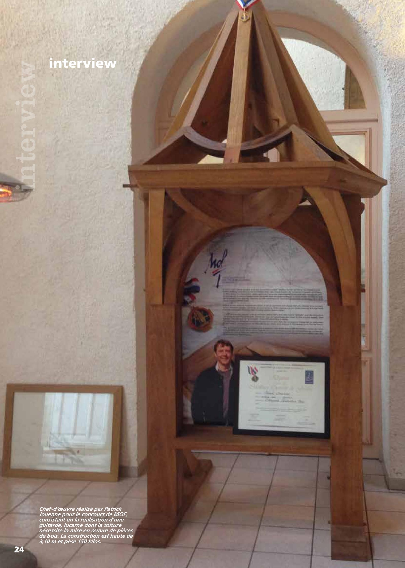
*Chef-d'œuvre réalisé par Patrick Jouenne pour le concours de MOF, consistant en la réalisation d'une guitarde, lucarne dont la toiture nécessite la mise en œuvre de pièces de bois. La construction est haute de 3,10 m et pèse 150 kilos.*
