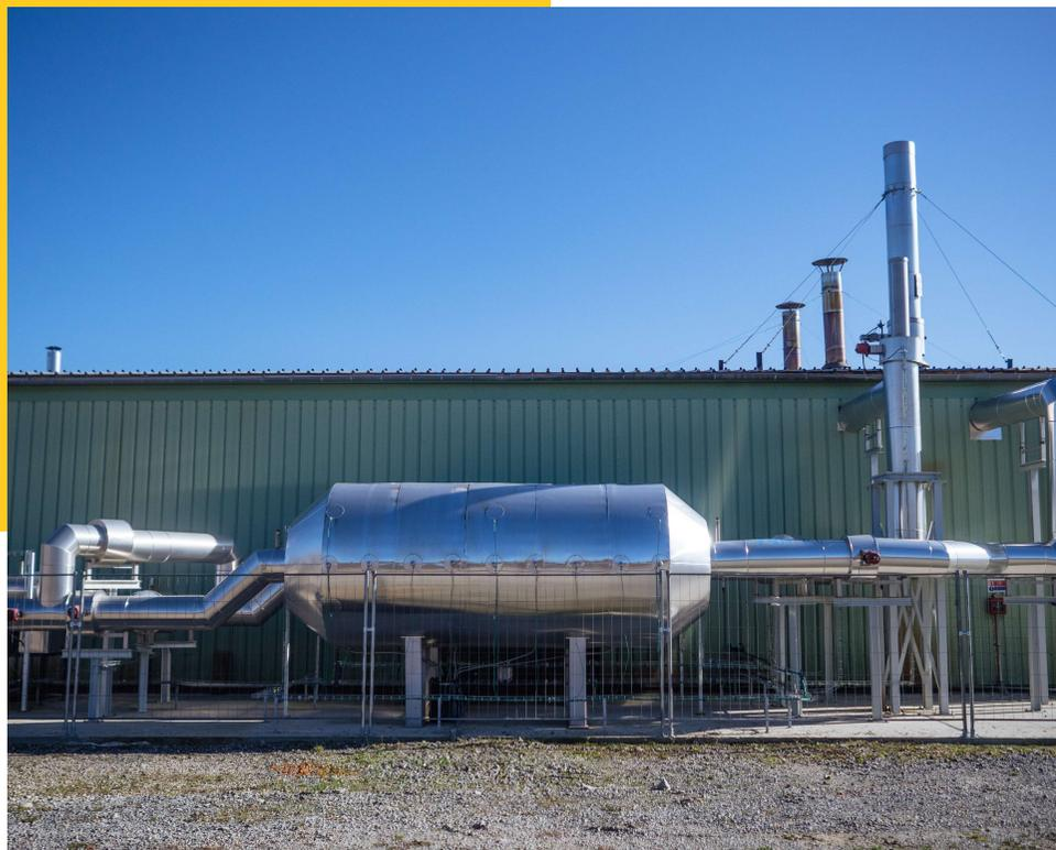
Eco-Tech Ceram a développé l'Eco-Stock<sup>®</sup> pour **capter, stocker et réinjecter** la chaleur des fumées d'usine à plus de 300°C.
