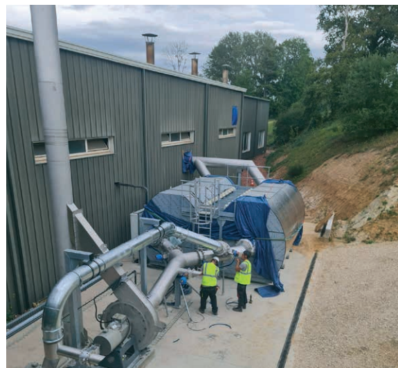
Mise en place des deux Eco-Stocks® sur le site de Pontigny.
